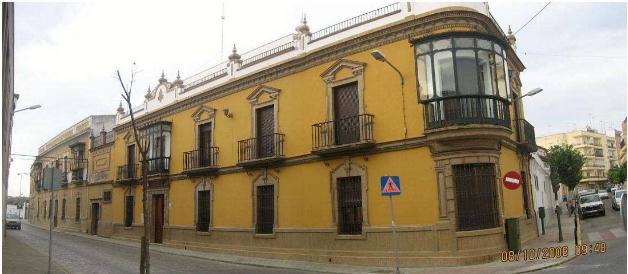
Vista de la Avenida de Coria. Acera oeste.
