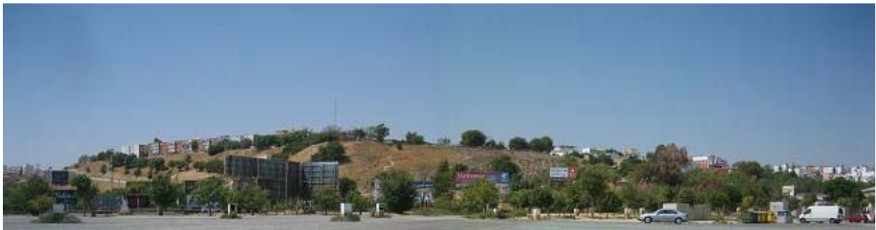
Vista de la Cornisa Este del Aljarafe, desde los terrenos de Minas de Cala
