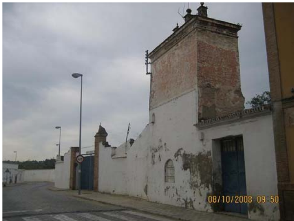
Vista de la Avenida de Coria, acera oeste.
