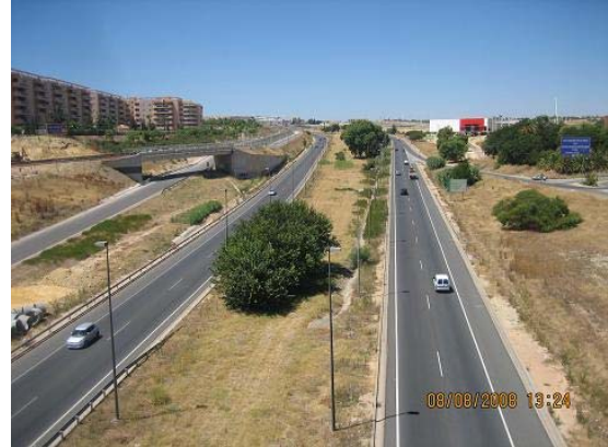
Autovía a Mairena. Vista hacia el suroeste
