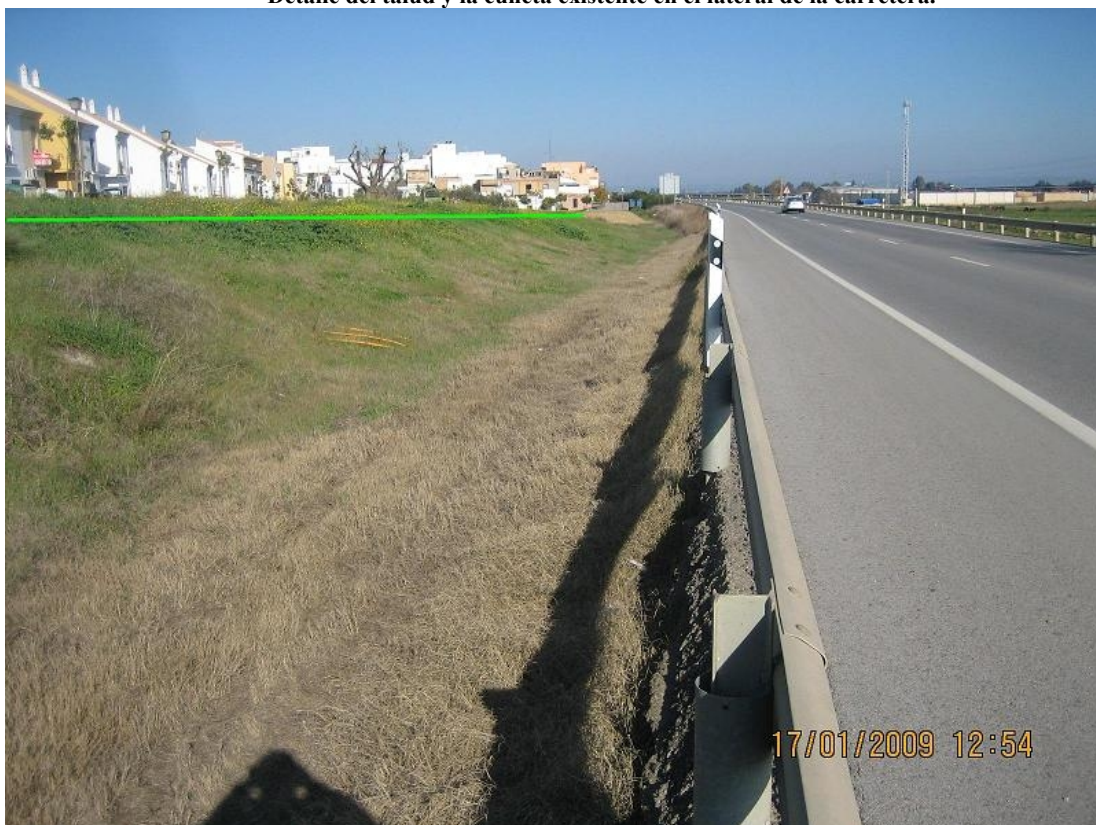
Detalle del gran talud existente en el lateral de la carretera. Al fondo la cuneta de drenaje.
