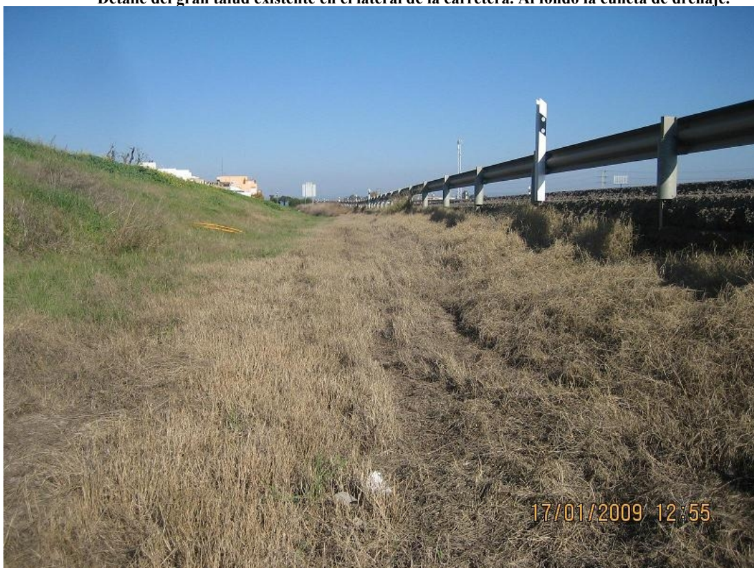
Detalle del gran talud existente en el lateral de la carretera. Al fondo la cuneta de drenaje.
