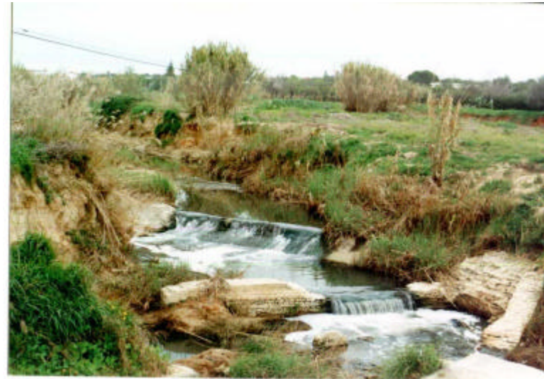
Restos de molino sobre el Riopudío entre Palomares y Almensilla
