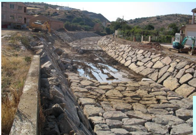
Encauzamiento en Herrera de los Navarros (Zaragoza)
