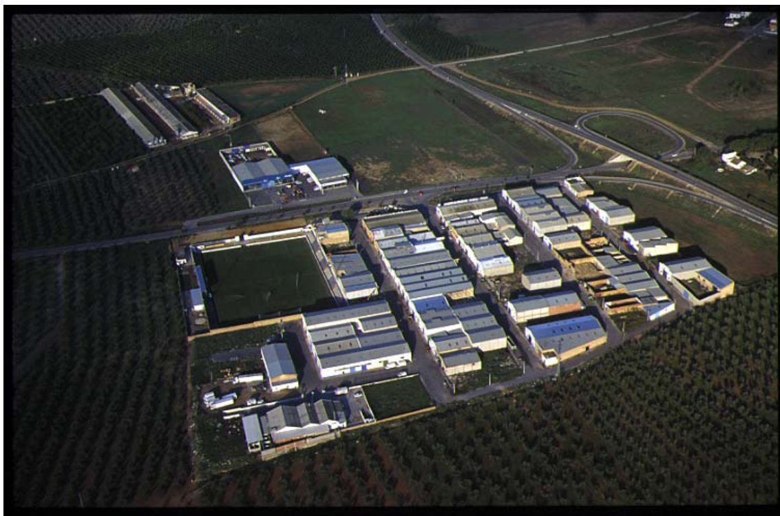
Polígono Industrial de los Ventolines en Pilas (1999)
