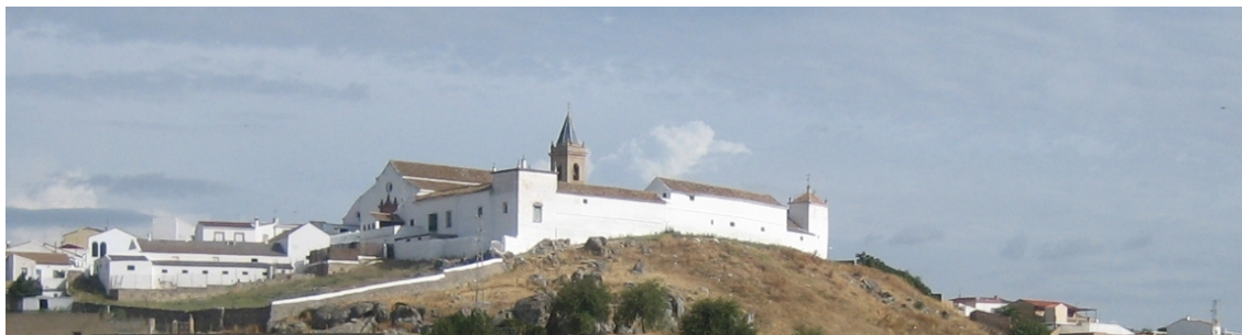
Vista actual del Cerro dominando el perfil urbano de Gerena, desde el sur este.
