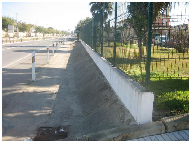
Innecesario sellado de suelos. Las cunetas verdes son una alternativa que retienen e infiltran agua y mejoran el paisaje.
