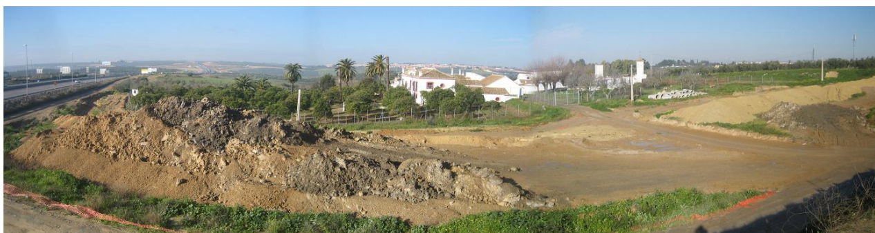
Panorámica de la hacienda desde la carretera A-8062 entre Gines y Bormujos. En primer término obras de acceso a la A-49 (paralizadas). A la izquierda la A-49. A la derecha el término de Gines.
