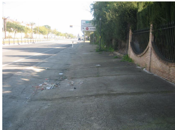
Innecesario sellado de suelos. Las cunetas verdes son una alternativa que retienen e infiltran agua y mejoran el paisaje.
