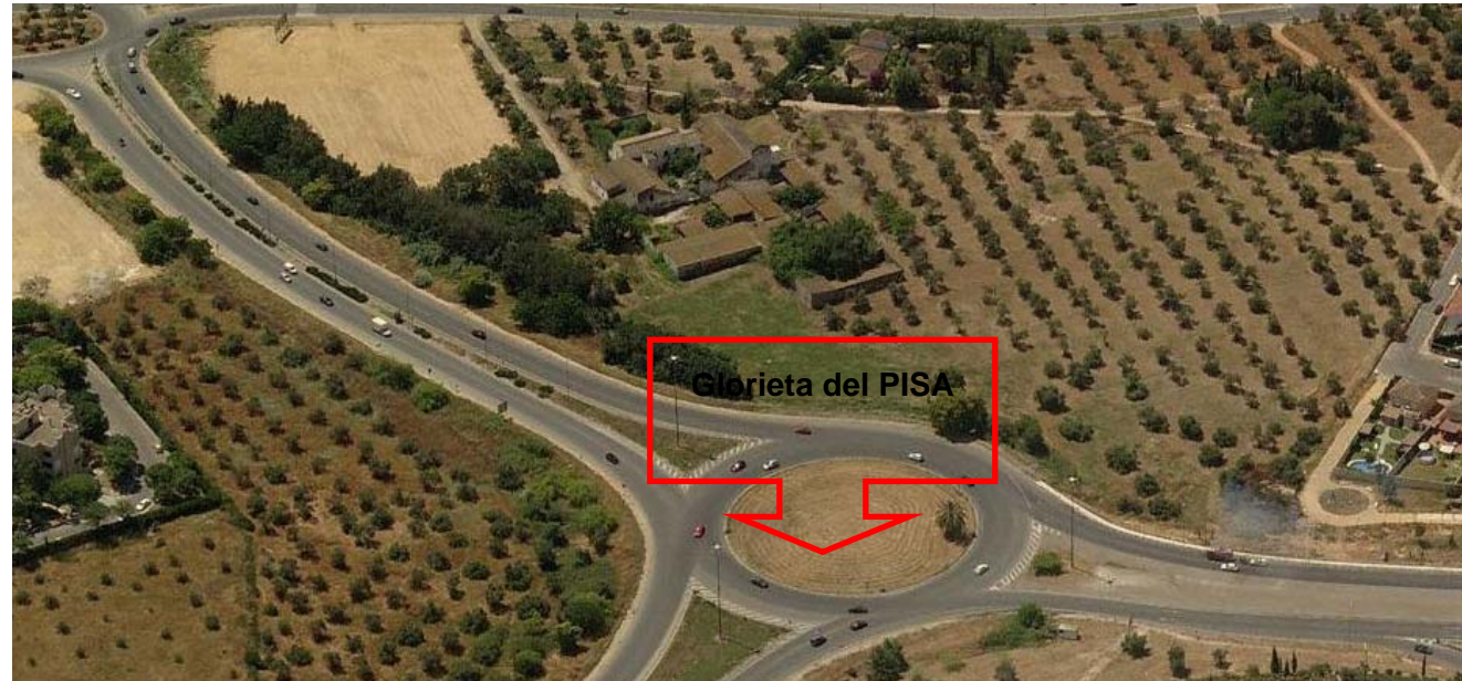
PP.KK. 0+400 – 0+520. Vista General de la zona entre la Glorieta del PISA y la A-8057 por la que discurre la plataforma reservada del transporte público
