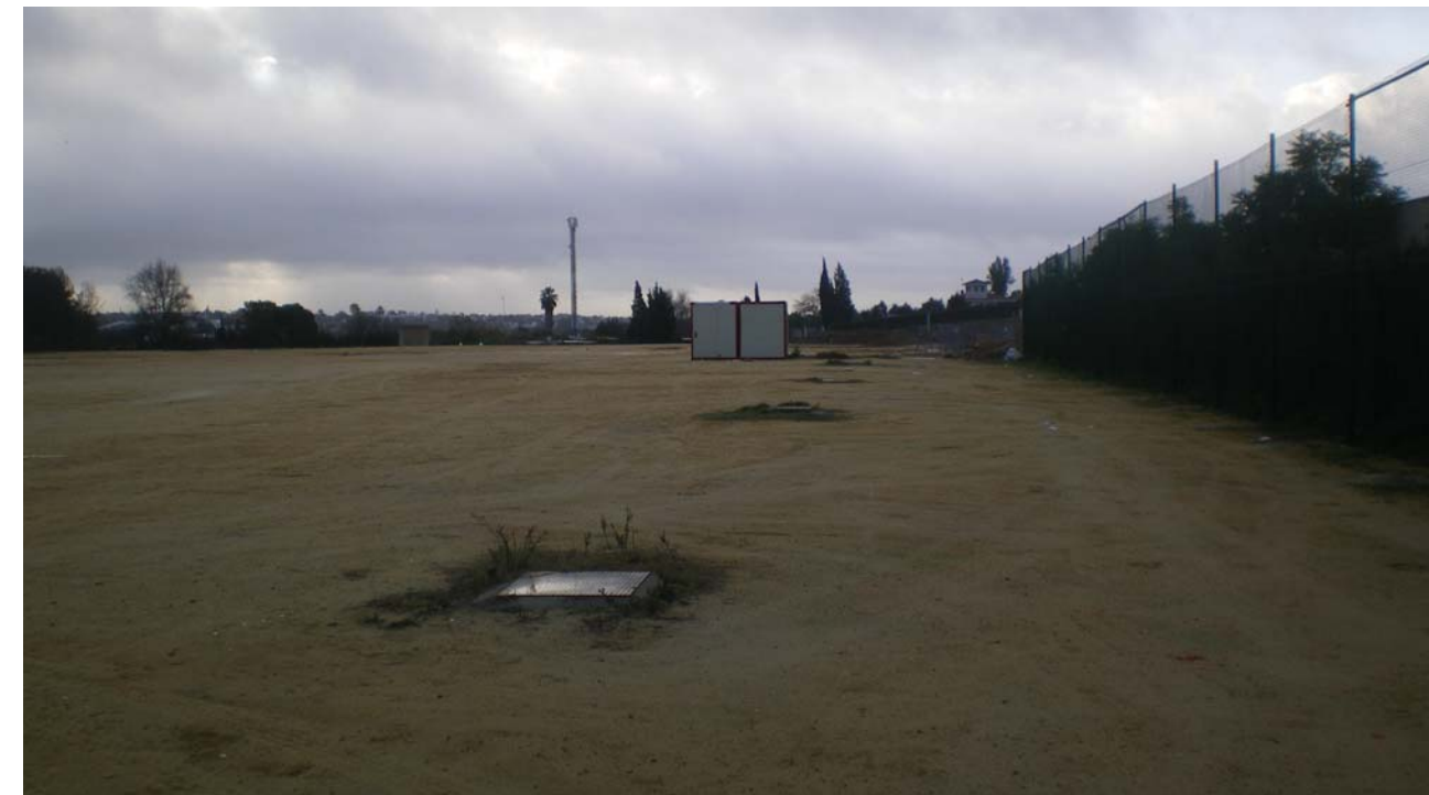
Fin de Tramo. PK 1+052,949. Vista hacia el Sur, donde conectará con el subtramo siguiente de la Plataforma Reservada de Transporte Público del Aljarafe en el tramo entre Coria y Mairena
