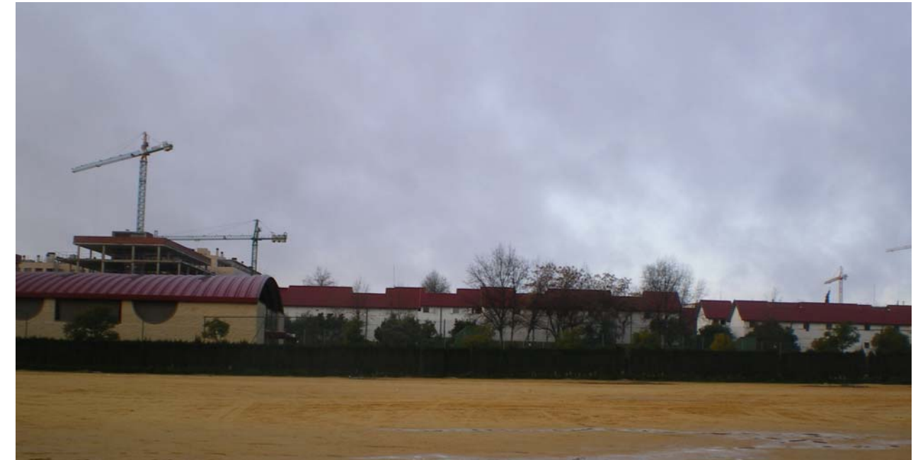
Actual recinto Ferial de Mairena del Aljarafe por el cual discurre el eje de la plataforma reservada.
