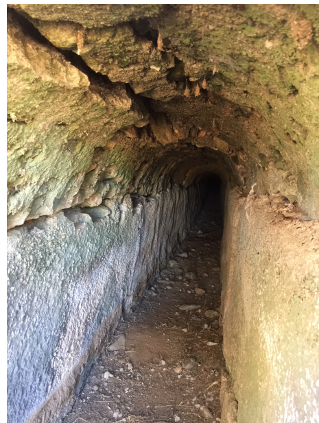
Acueducto de Itálica en La Pizana
