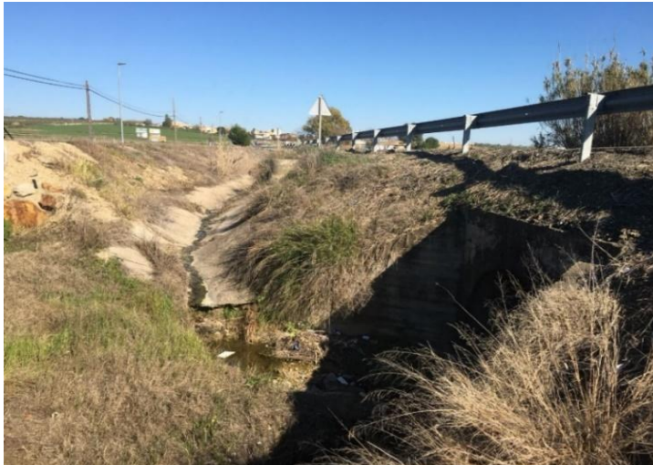
Figura 7. Entrada al arroyo Riopudio del drenaje de la cuneta de la carretera a Salteras.
