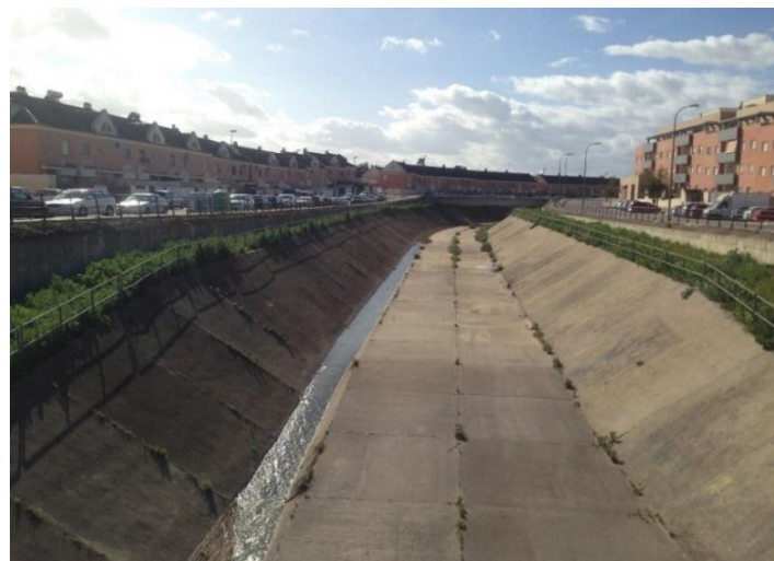
Figura 10. Canalización del tramo de desembocadura del arroyo.
