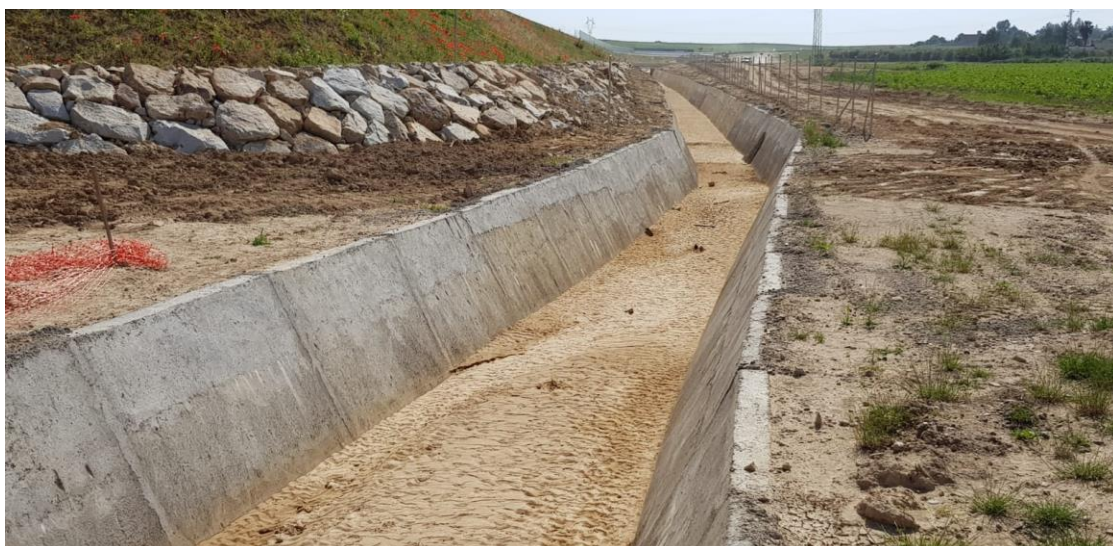
Figura 24. Implantación de cunetas hormigonadas en la futura SE-40, en su trazado paralelo al Riopudio. Fuente: Leandro del Moral Ituarte
