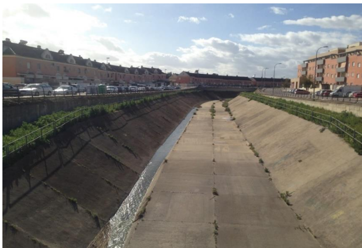
Figura 23. Canalización del tramo de desembocadura, en el municipio de Coria del Río. Fuente propia.
