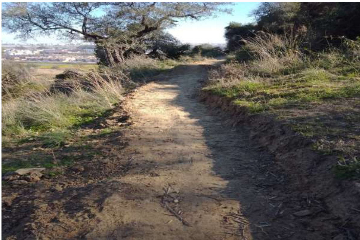
Fig 1. Detalles de rebajes manuales para ensanchar antiguos caminos de usos pecuarios y veredas de paso, con el objetivo de mejorar la circulación ciclista en la zona. Factores estos que provocan más velocidad a los usuarios de las bicicletas de montaña y puedan ser usados por motos.
