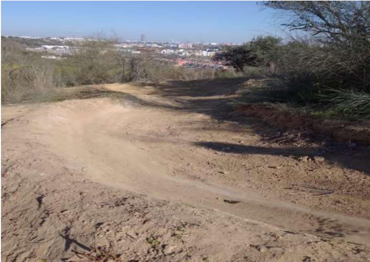
Fig 3. Construcción de peraltes y ensanches de los zigzag en zonas intermedias de las laderas para atenuar la velocidad del uso de la bici con los consiguientes movimientos de tierras que esto lleva asociado.
