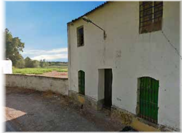
Edificaciones rústicas en el margen izquierdo de la carretera
