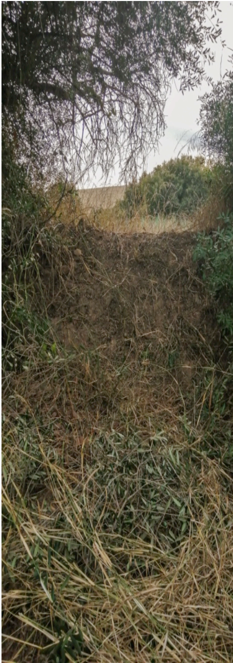
Estado de la traza en el tramo medio, desde dentro y hacia el este
