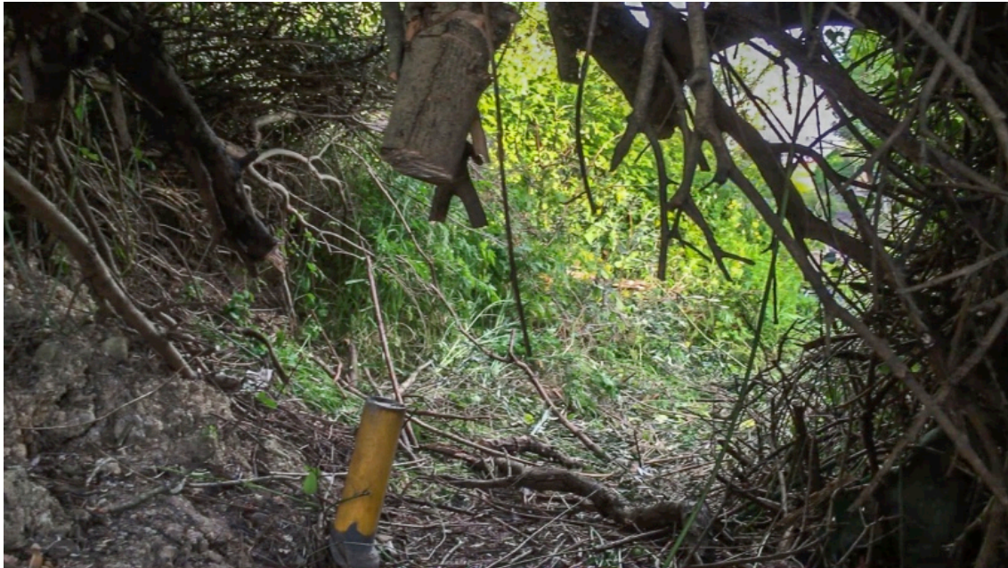
Prueba de desbroce en extremo inferior.1
