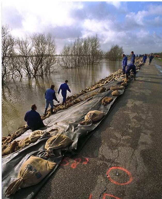
**Figura 12. Fotografía de operarios colocando estructuras de protección frente a inundaciones. Fuente: Hofstra, 2009.**
