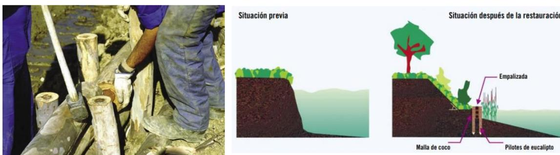
**Figura 6. Instalación de empalizada de madera para estabilización de taludes (izq.) y esquema de la técnica (dcha.). Fuente: Arenas *et al.*, 2008.**
