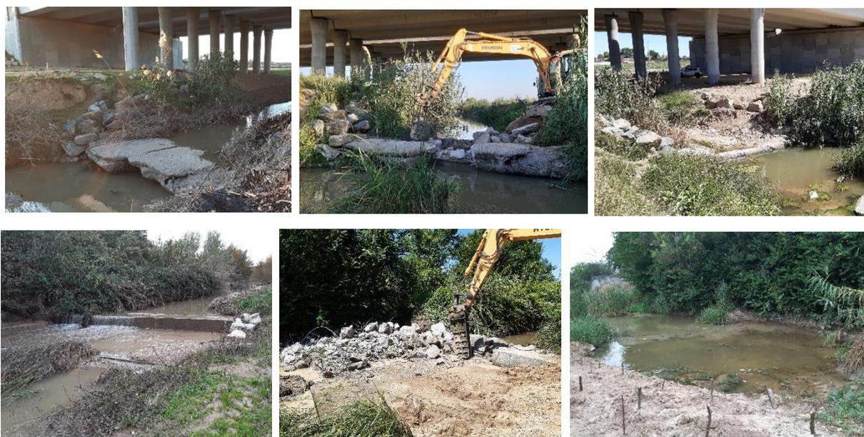
**Figura 7. Evolución de los trabajos de recuperación de la conectividad longitudinal (arriba, demolición de azud ‘SE-40’; abajo, demolición de azud ‘Madre Vieja’).**
