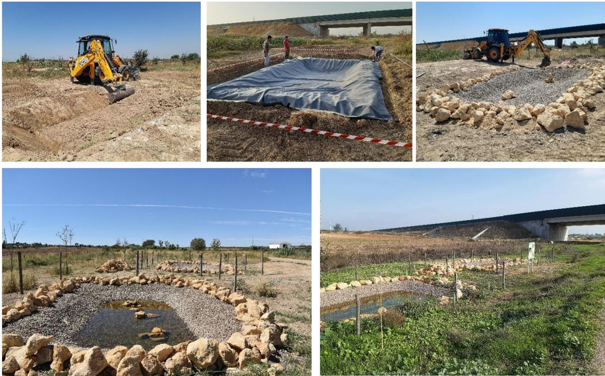
**Figura 10. Evolución de los trabajos de construcción de charcas para anfibios.**
